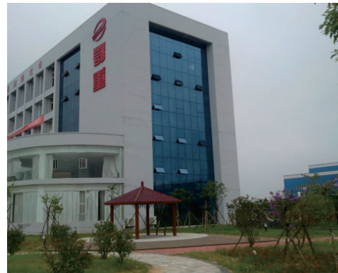
Instalaciones de EZHONG en Ezhou.
